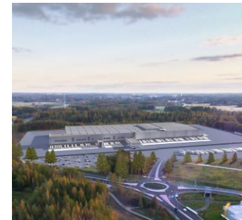
LIDL JAKELUKESKUS: MIKROVERKKO JA ÄLYKÄS ENERGIARATKAISU
